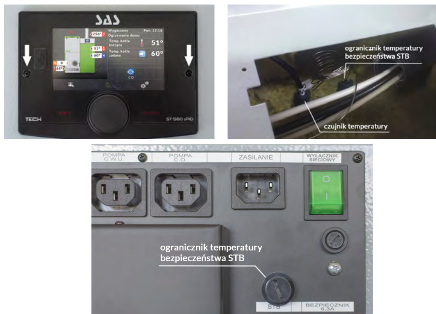
Rysunek 9 Lokalizacja ogranicznika temperatury bezpieczeństwa STB oraz czujnika temperatury
